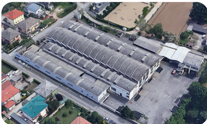
Production Facility - Borsano di Busto Arsizio (VA)
